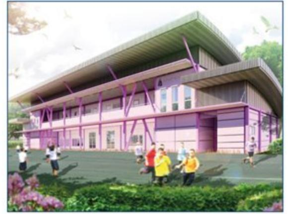
อาคารที่ออกแบบเป็นโครงสร้างเหล็ก รับแรงสั่นสะเทือนจากแผ่นดินไหวที่ใส่แกนแรง (Bracing) ตามตำแหน่งที่กำหนดไว้ เป็นมุมทแยงระหว่างโคนเสาไปยึดกับบริเวณใกล้เคียงกับกึ่งกลางช่วงคาน Bracing แต่ละตัวยึดเยื้องกัน เมื่อวาง Bracing แล้วตรงคานจะมีช่วงห่างสั้น ๆ เรียกตัวเชื่อม (Link) ไม่เกิน 60 เซนติเมตร ตำแหน่งตรงนั้นเป็นจุดที่กำหนดให้วิบัติด้วยแรงเฉือน แต่ไม่ถึงกับหักพัง เมื่อมีการขูดงมาแล้วก็เกิดการสลายแรงแผ่นดินไหวทำให้อาคารทั้งหลังยังตั้งอยู่ได้ และสามารถเข้าไปซ่อมแซมได้ตรงจุดที่เสียหาย
